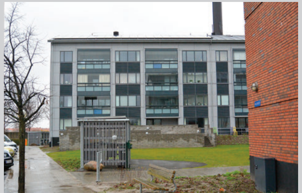
Hornemannsvænge housing retrofit in Valby
