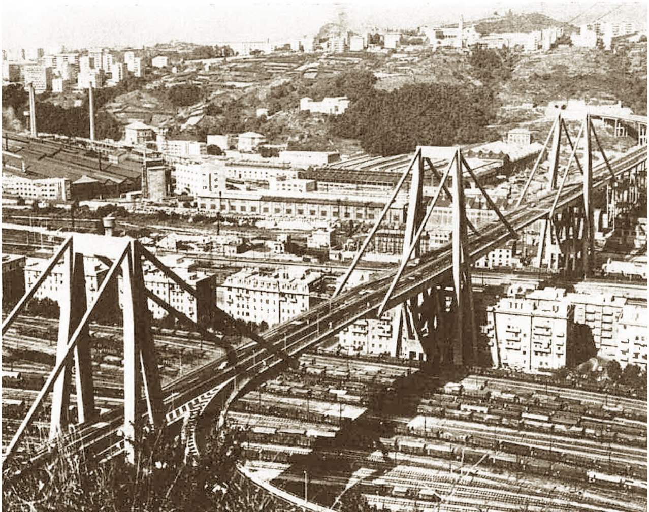
Photo 2: Morandi R.: Viaducto sobre el Polcevera, en Genova – Italia, Informes de la Construcción, Vol. 21, No. 200, 1968, 57-88
